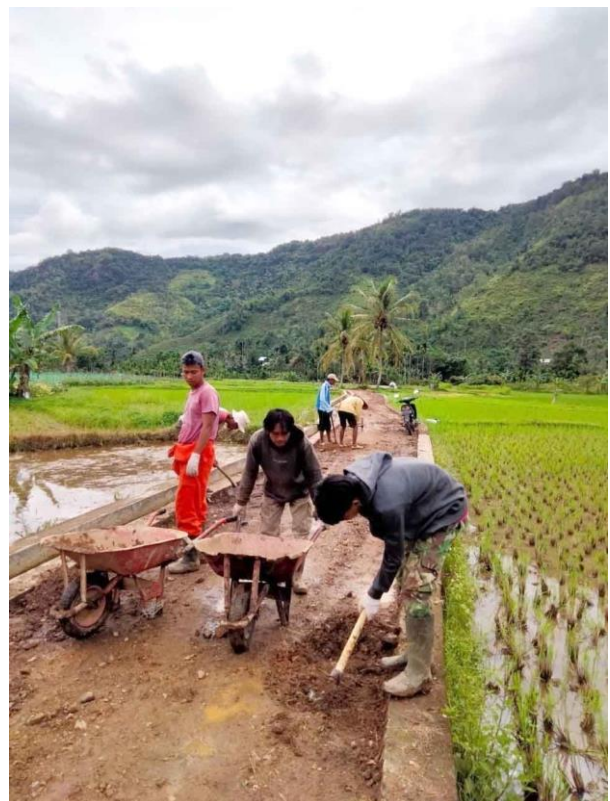
Pekerja sedang membangun jalan rabat beton Usaha Tani Masjid Kubang. (Foto: Nur Fajri)
