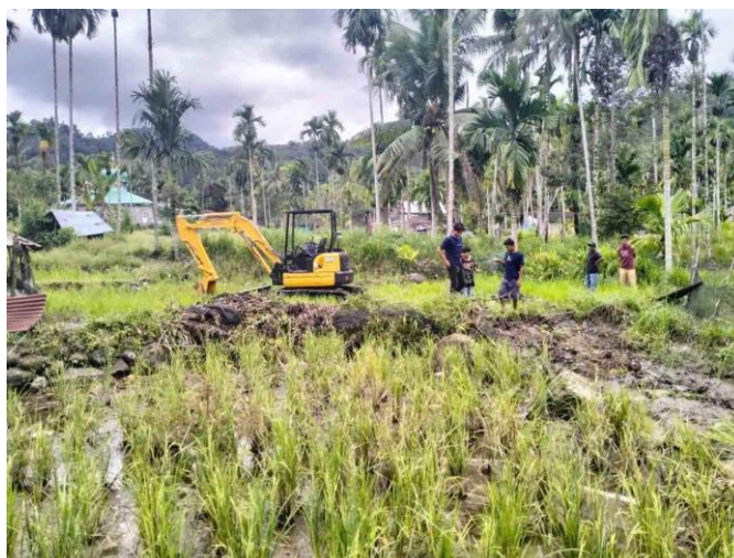
Ekskavator sedang bekerja di lokasi yang direncanakan akan dibangun tower Telkomsel di Jorong Musus di Nagari Ganggo Hilir, Kecamatan Bonjol, Pasaman. (Foto:
